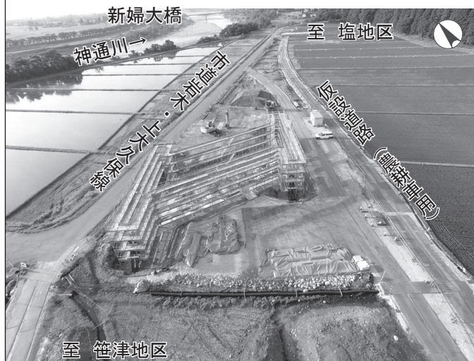
岩木新地区道路改良工事 (南から北方向に向けて)
