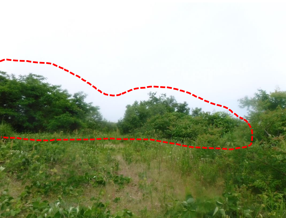
常願寺川④ 立山町利田地先 6.2k付近 右岸約600m 2
