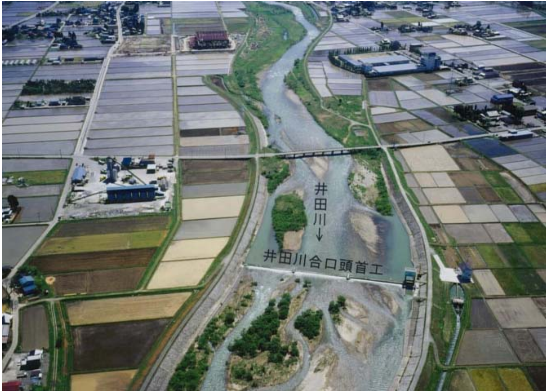
井田川合口頭首工（井田川12.05km）
