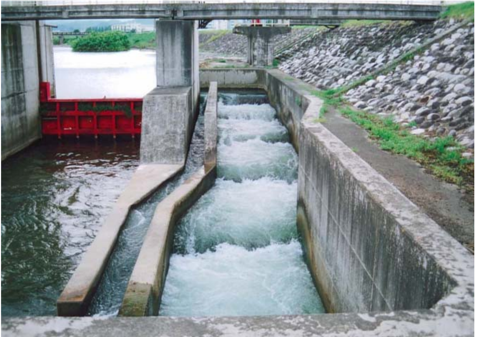
井田川合口頭首工（井田川12.05km）
