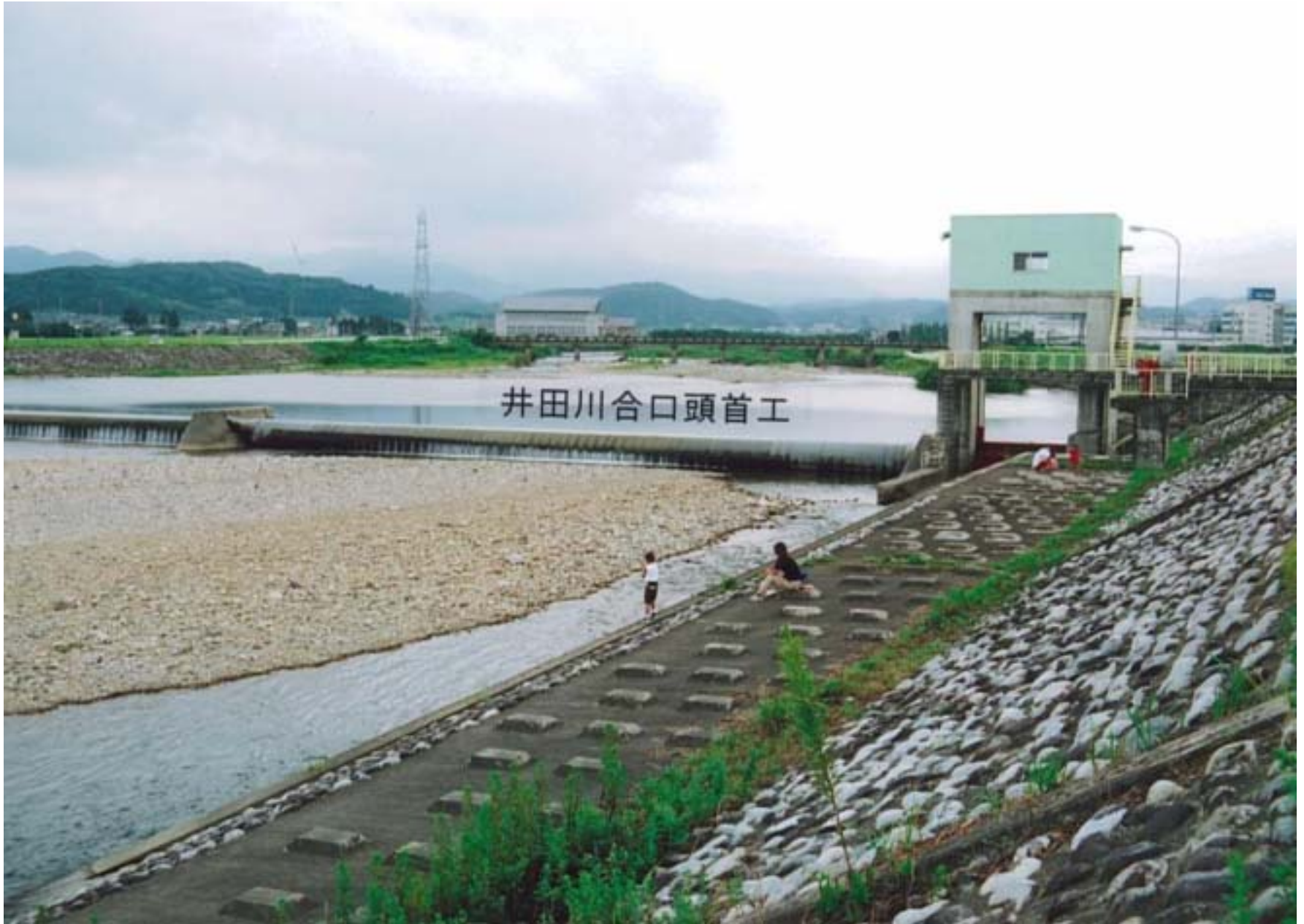
井田川合口頭首工（井田川12.05km）
