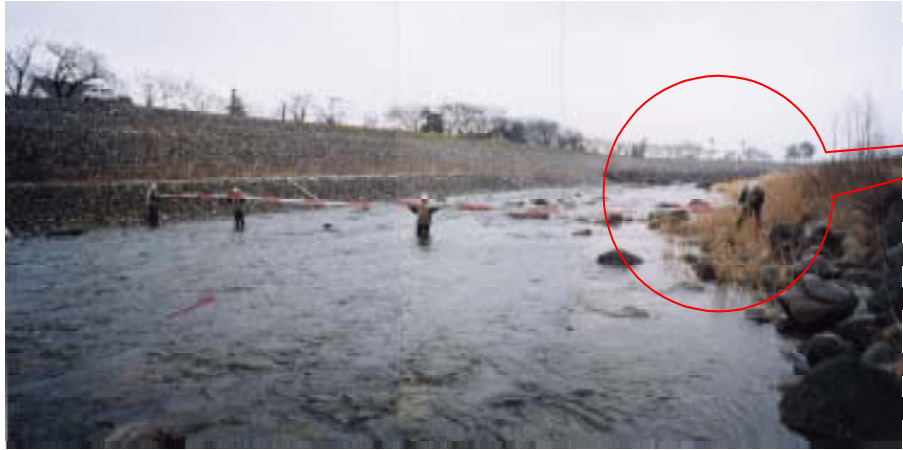
流量観測地点全景(庄川・船戸橋地点)
