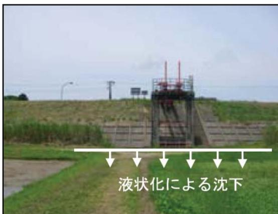
図 5-15 液状化による河川管理施設の沈下
