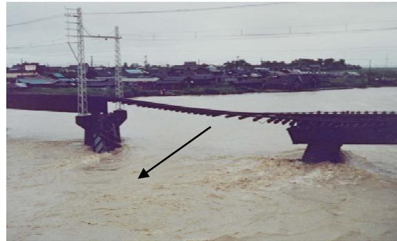
図 5-8 洪水時の洗掘による鉄道橋梁の落橋
