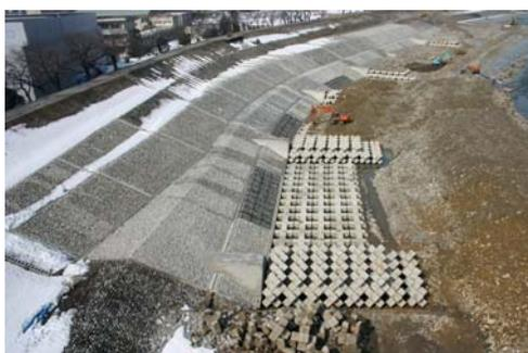
図 5-12 急流河川対策（根継ぎ護岸工）
