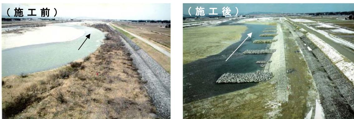
図 5-21 多自然川づくりの施工事例 ～ 自然石を用いた水制で新たに淵を創出する～
