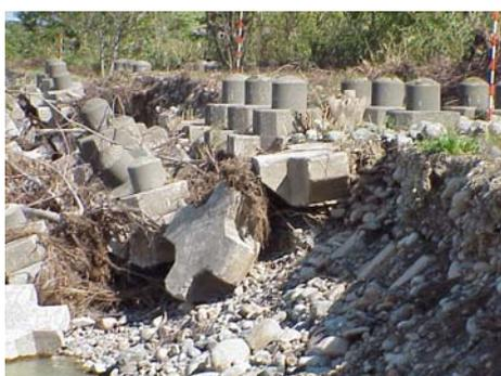
図 5-10 洗掘による被害
