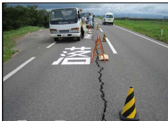
図 5-16 地震による堤防上面の亀裂
