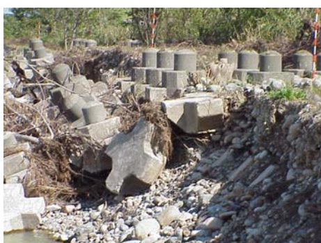
図 5-10 洗掘による被害
