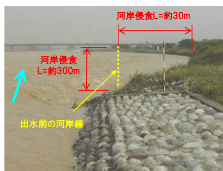
図 5-11 河岸の侵食状況（H11洪水）
