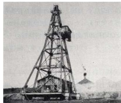
図3-9 タワーエキスカベーターによる河床掘削
