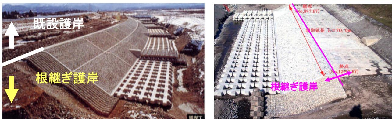
図 5.4 急流河川対策工 (根継ぎ護岸)
