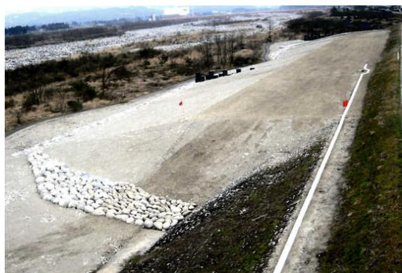
図 5.6 急流河川対策工(前腹付け工)
