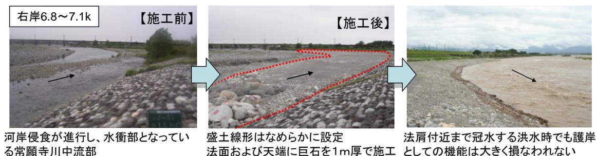
図 5.9 巨石を用いた河岸侵食対策
