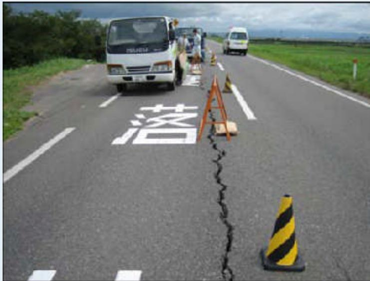
■中越沖地震による堤防上面亀裂(信濃川大河津分水路)
