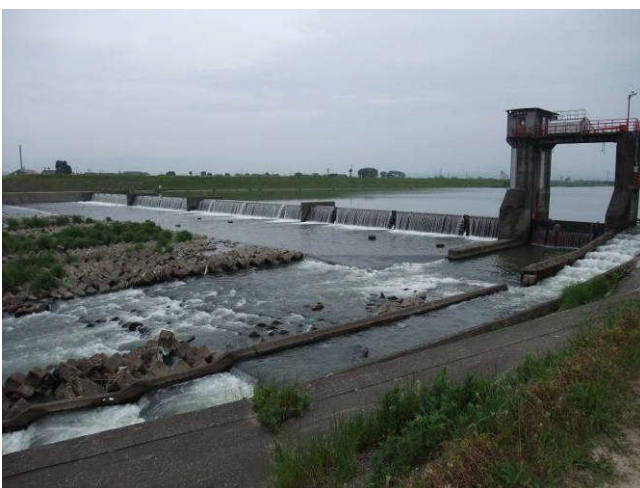
■五位庄頭首工
