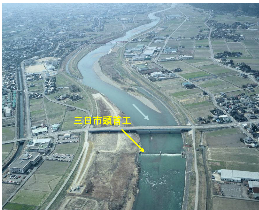
■三日市頭首工周辺の状況
