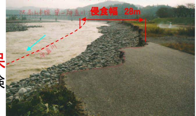
H16年10月洪水護岸欠壊(R17.8k付近)
