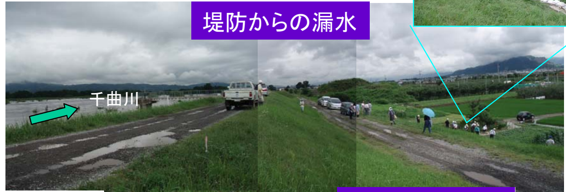
平成18年7月梅雨前線出水 漏水箇所 (千曲川:長野県 須坂市村山地先)
