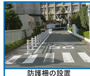
防護柵の設置
