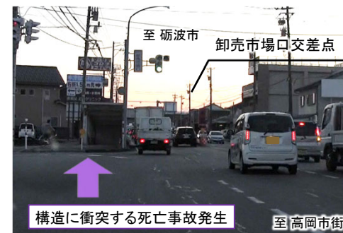
図-24 死亡事故発生箇所の状況
