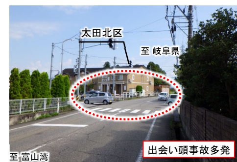
図-34 死亡事故発生箇所の状況
