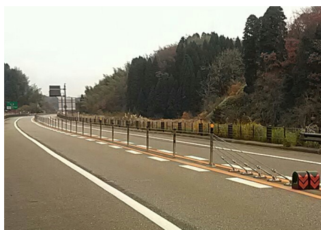
ワイヤーロープ式防護柵設置状況
