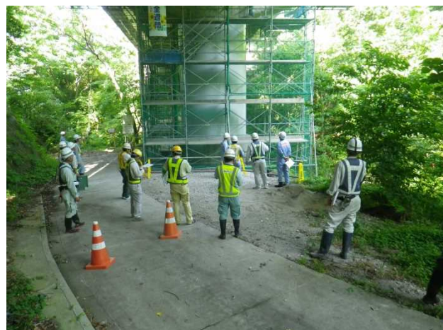
黒部地域道路地区 (H28.6.21)
