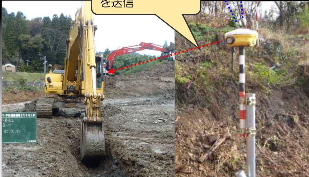
GNSS基地局では衛星から得たGNSS座標を現地のローカル座標にリアルタイムに整合。整合した補正データは、移動局に送信される。
