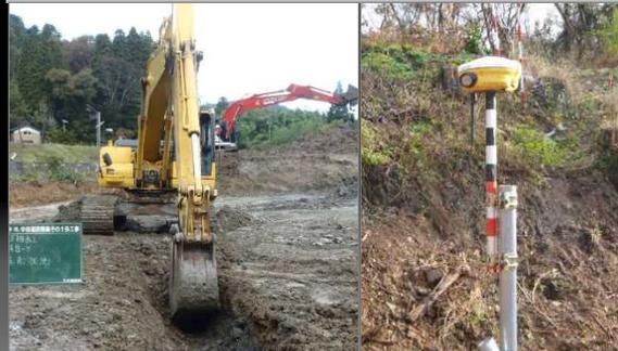
GNSSを用いたMGバックホウ
