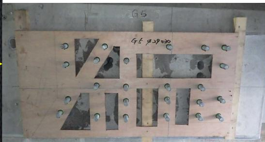
原寸図を基に作成した型枠板で、
