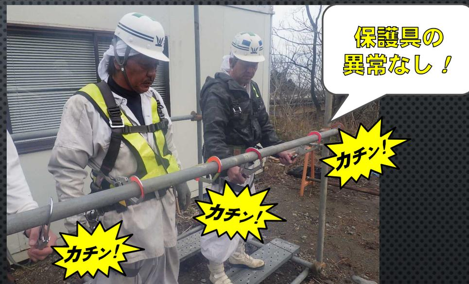
特に危険性の高い高所作業である足場の設置・撤去時にはハーネス型の2丁掛け安全ベルトの着用を徹底し、ゲートにて作業前点検を徹底した。
