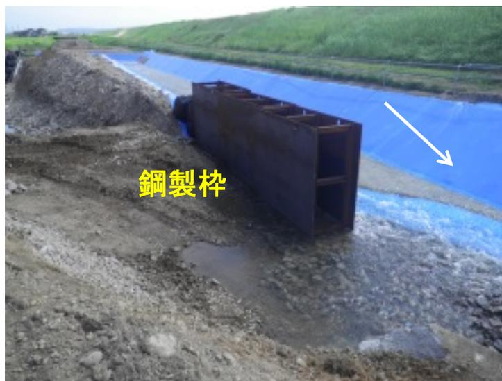
吐口部に鋼製枠設置し補強
