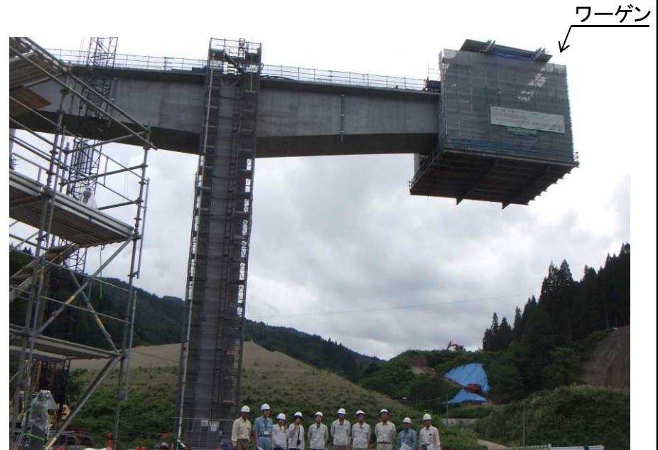
施工中の下島大橋(張出し工法)
