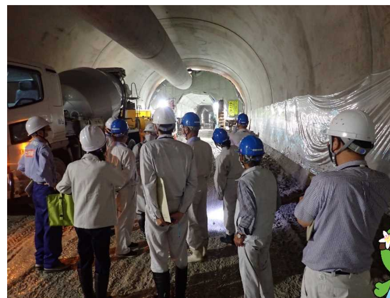
利賀トンネル工事の進捗状況を確認
