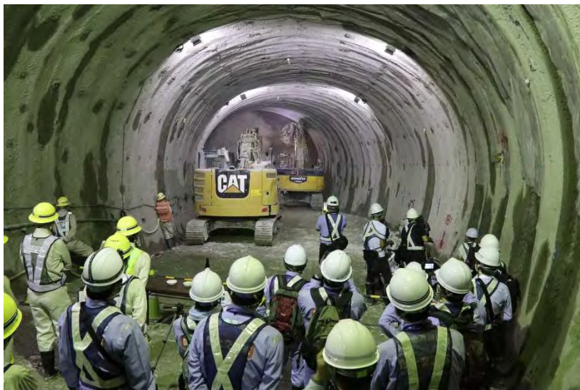
トンネル貫通作業を見守る関係者
