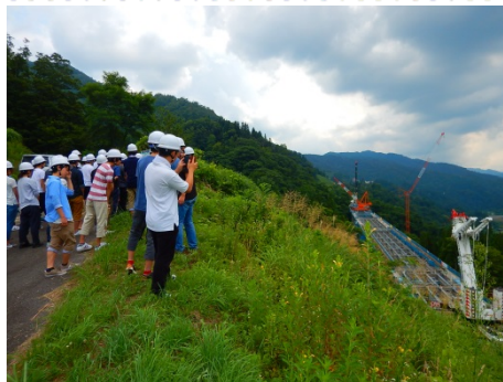
工事が進む豆谷橋梁
