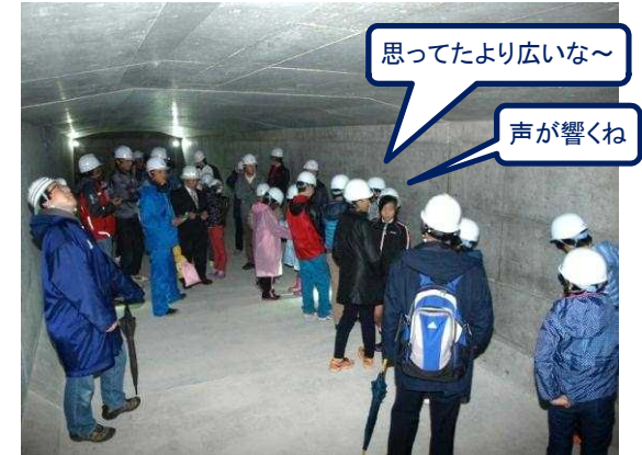
⑦親子で橋桁内部の見学
