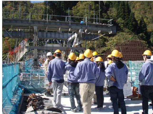
学校の先輩から工事の概要を説明
