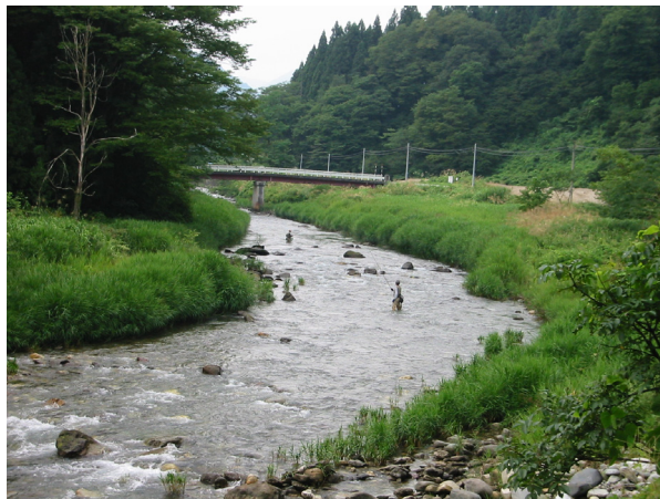
写真 4.9-4 利賀川(下島橋～万世橋)の状況
