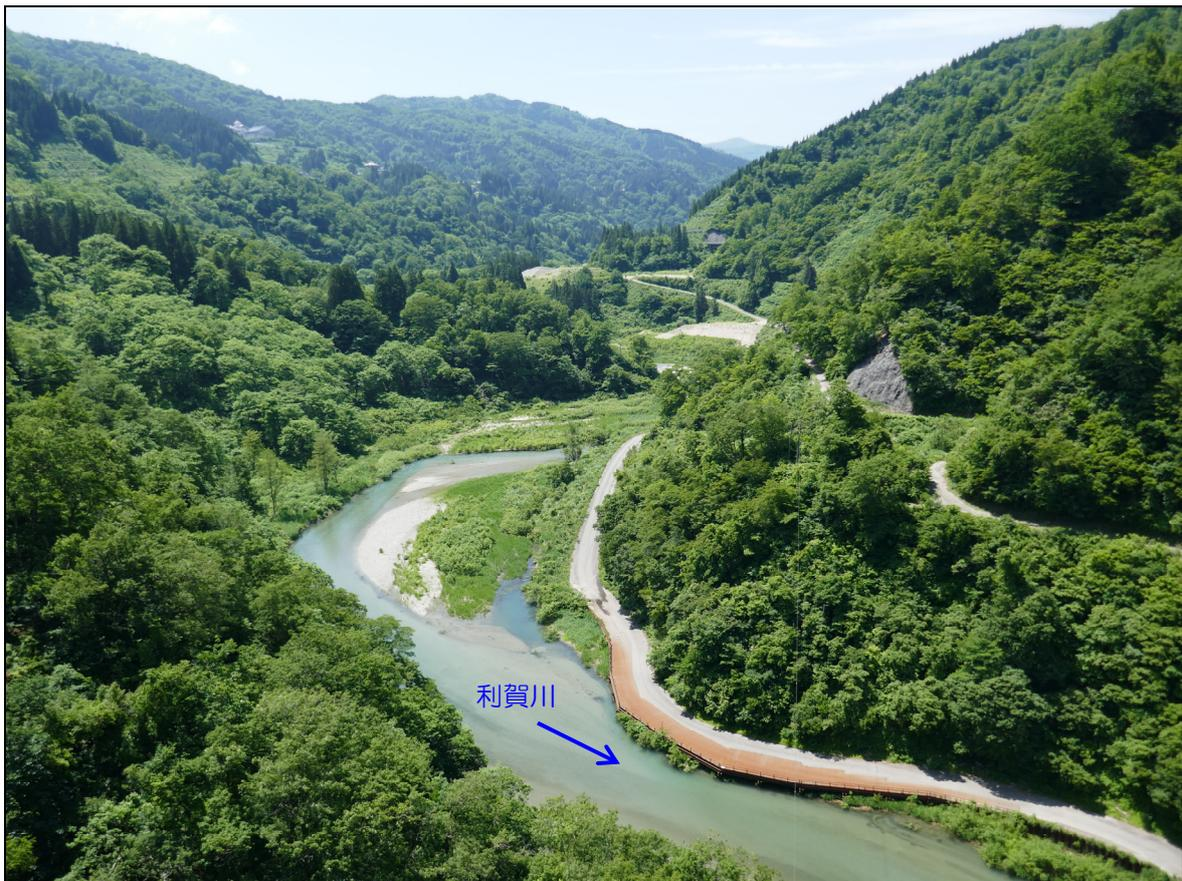
図 4.7.3-4 既設の豆谷ダム貯水池上流部での堆砂状況(令和元年6月撮影)
