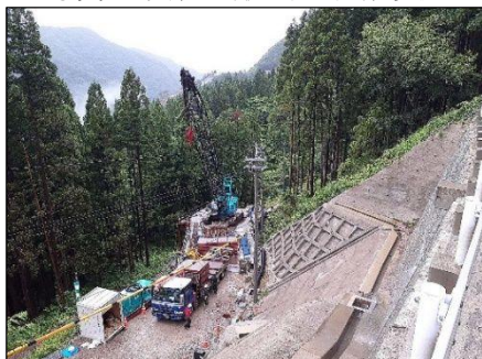
写真-4 資材運搬車両 待機状況
