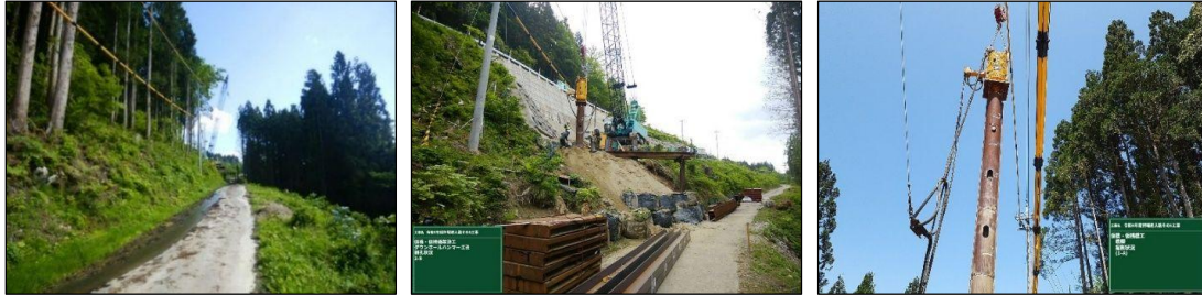
写真-2 架空線防護管 設置状況
