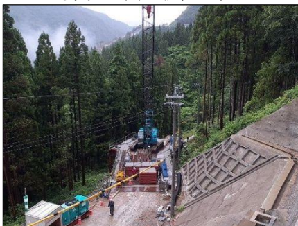
写真-5 鋼材 仮置き状況
