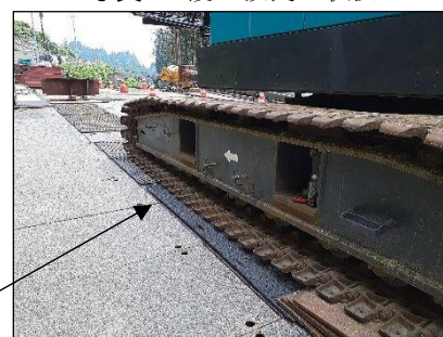
写真-6 覆工板養生状況
