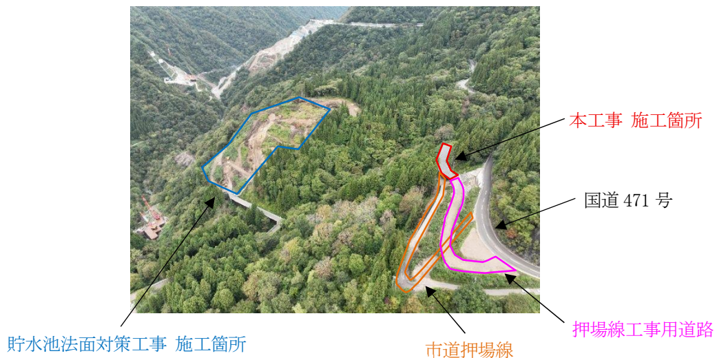
写真-1 施工箇所周辺
