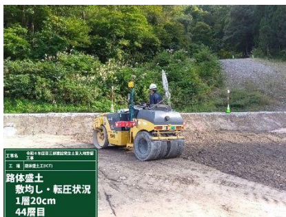
路体盛土転圧状況
