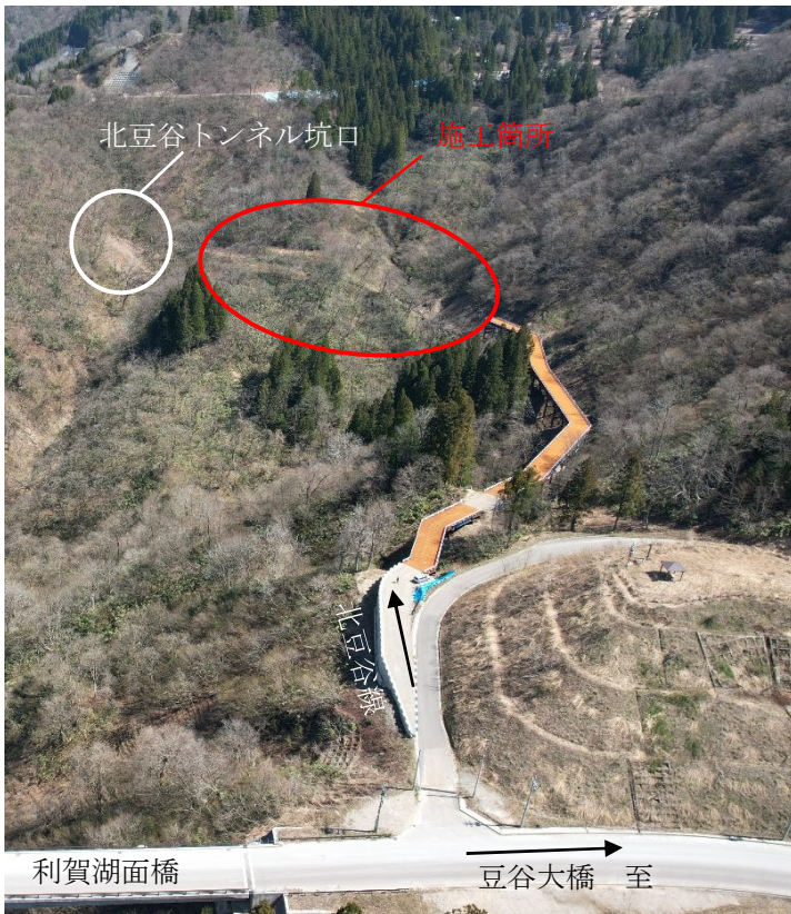
【当初：北豆谷地区進入路全景】
