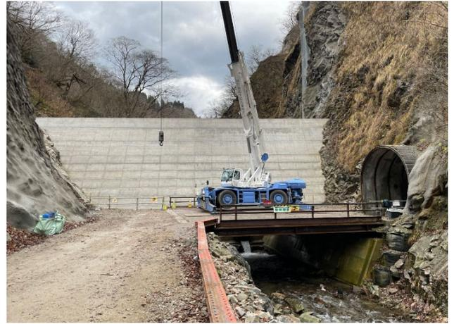
写真-5 上流仮締切堤施工状況
