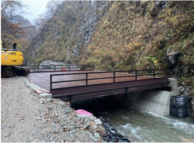
写真-4 作業構台施工完了
