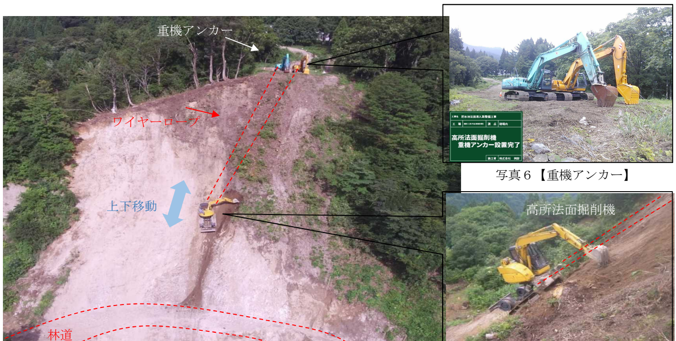
写真5 【高所法面掘削機による掘削：全景】
