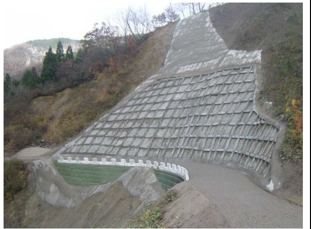
写真4 【完成：斜面对策工】
