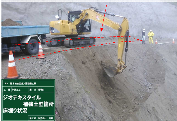
写真11【補強土壁地山掘削】
