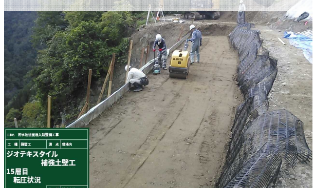
写真13【補強土壁施工】
