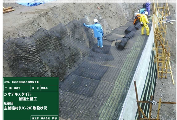
写真12【補強土壁主補強材敷】
