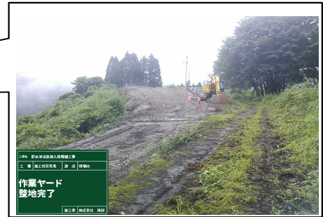
写真9 【工事様搬入路整備】
