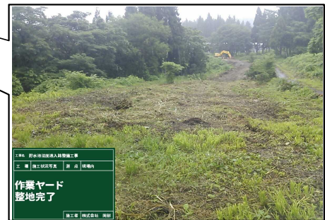
写真10 【重機・資材ヤード】
