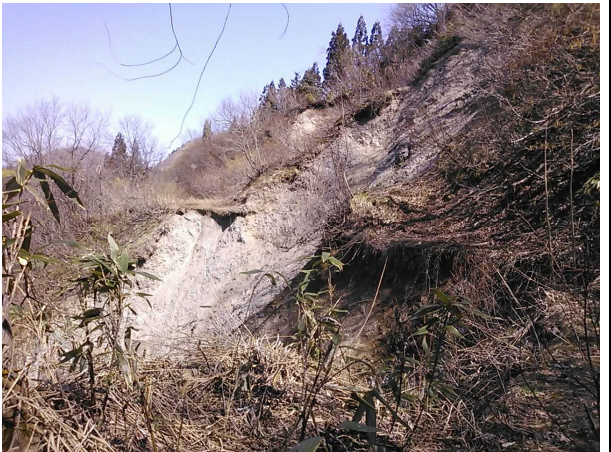
写真3 【当初：斜面崩落状況】
