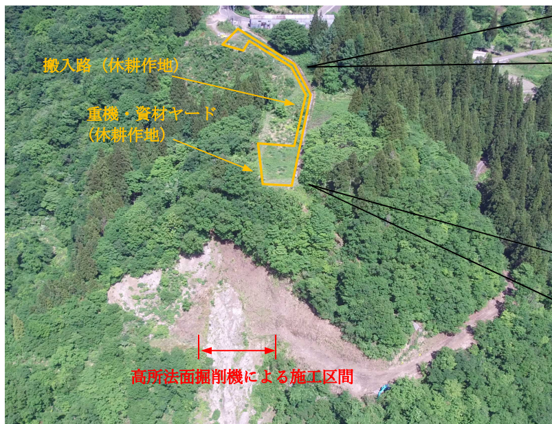
写真8 【搬入路および重機・資材ヤード：全景】
