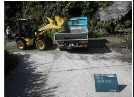
広く平坦な場所での積込作業
