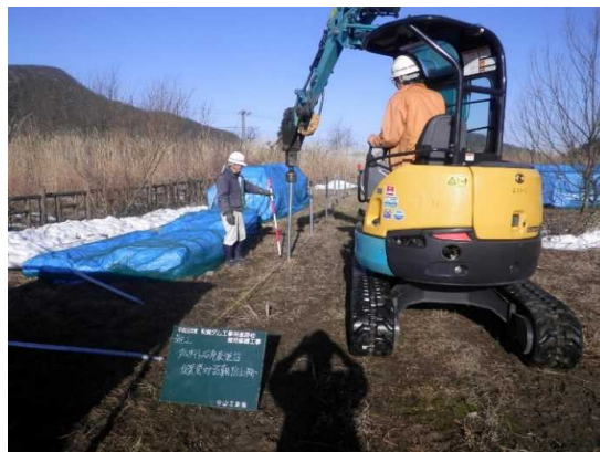
油圧ブレーカーによる打込み作業状況
