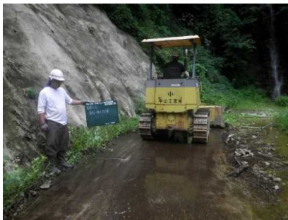
ブルドーザーでの集積状況
