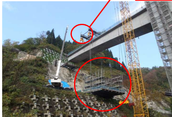
地上付近にて解体
