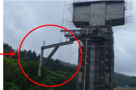
柱頭部ブラケット大払い状況
