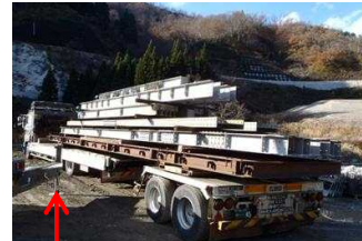
主梁運搬状況
