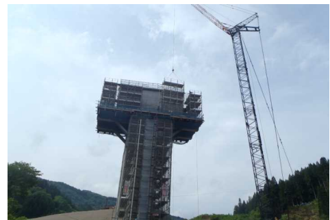
柱頭部足場解体状況
