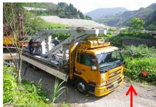
主構運搬状況
