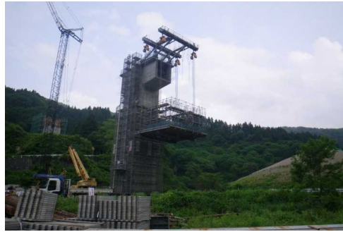
足場一括吊上げ状況
