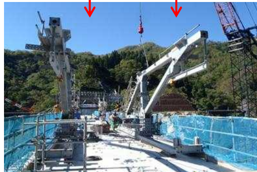
移動作業車一括組立・解体状況
