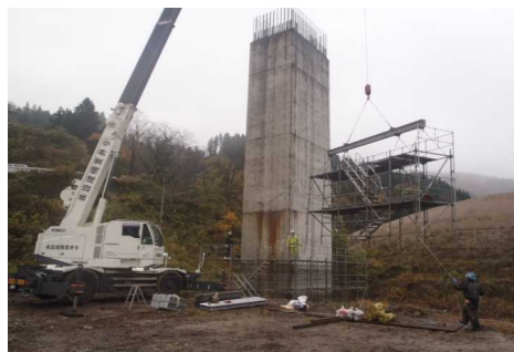
脚頭部足場組立状況
