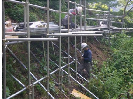
横坑修繕に伴い重量物の運搬が中心となるため、通路の勾配変化は極力緩やかとし、突合せ継ぎとする。
