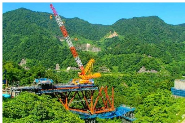
シクルビ谷の橋梁上部工事
