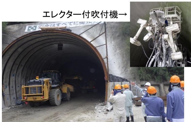
利賀トンネル(河床進入)工事では、トンネルの掘削現場を見学しました。岩盤に孔を掘るドリルジャンボや切羽にコンクリートを吹き付ける吹付機、大型ブレーカーなどの大型重機が稼働しており、トンネル工事の規模の大きさに圧倒されました。トンネル工事を間近で見学することができ、良い経験になったと思います。
