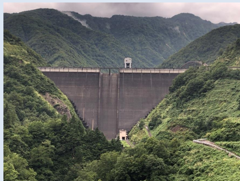
下流より境川ダムを望む
