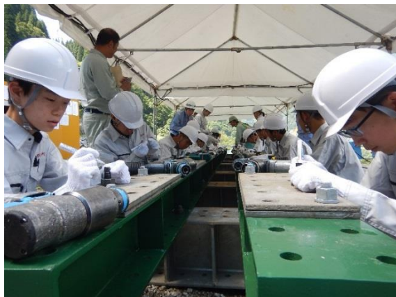
ボルト締め体験(シクルビ谷橋)
