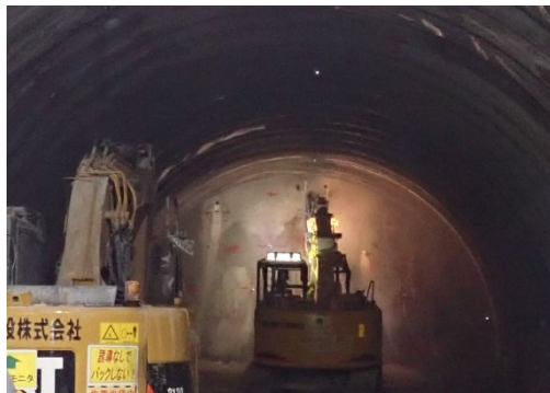
トンネル掘削作業中
