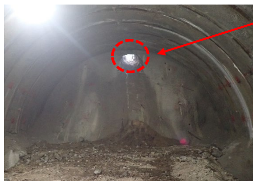
トンネル貫通の様子
