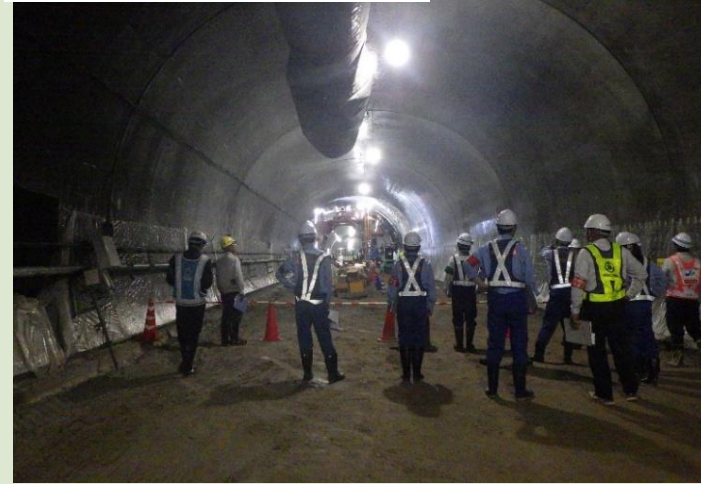
⑨利賀トンネル（1工区）工事
