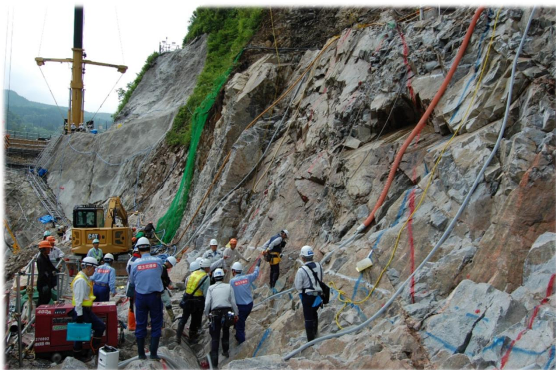
ダム堤体先行打設ブロック岩盤検査の様子(令和7年7月9日)
