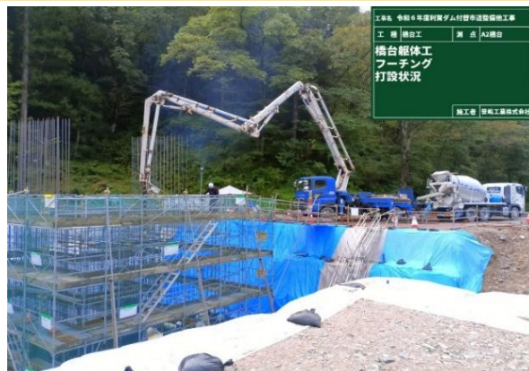
仮締切及び橋台の施工状況
