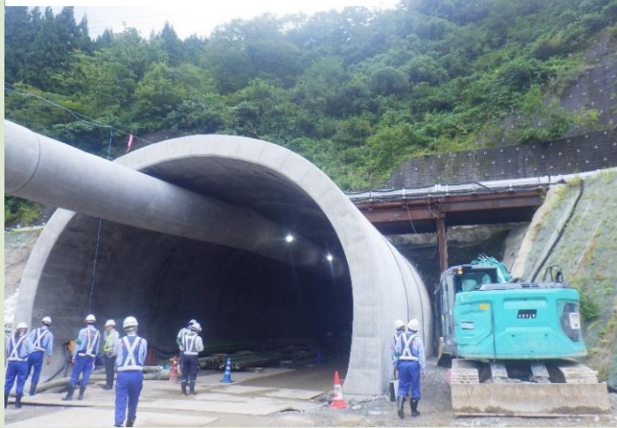
⑨利賀トンネル（1工区）工事
