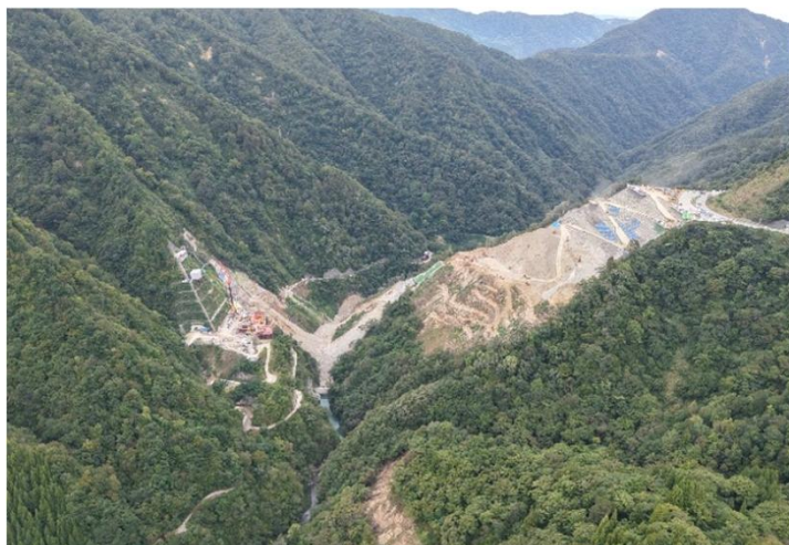
ダムサイトの現地状況（R7. 10月初旬）
