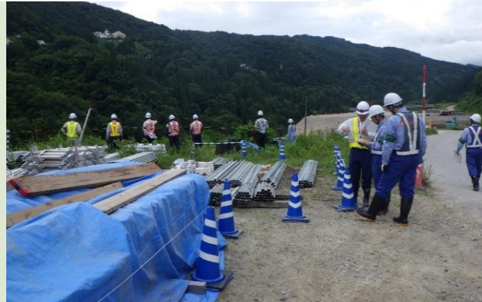
①利賀ダム本体建設（第1期）工事 【下島骨材置場】
