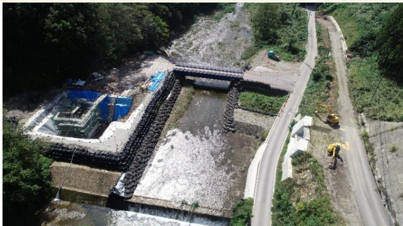
仮締切及び橋台の施工状況
