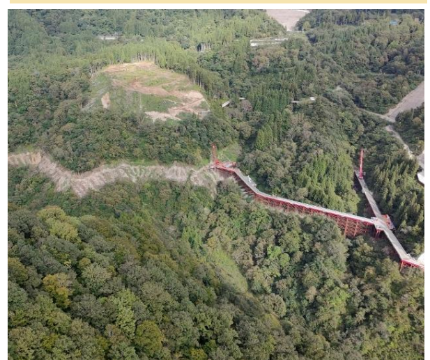
10月初旬の工事進捗状況
