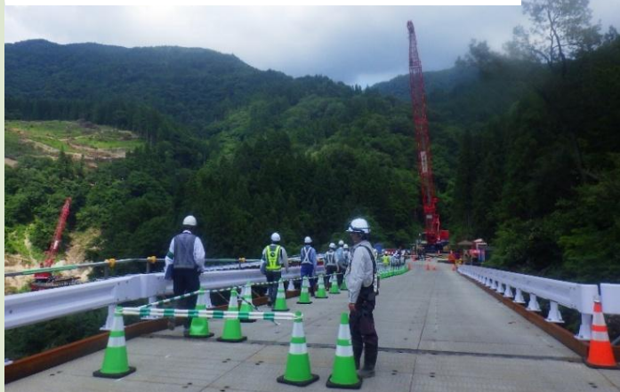
②押場地区貯水池法面对策（第1期）工事 【仮栈橋工】
