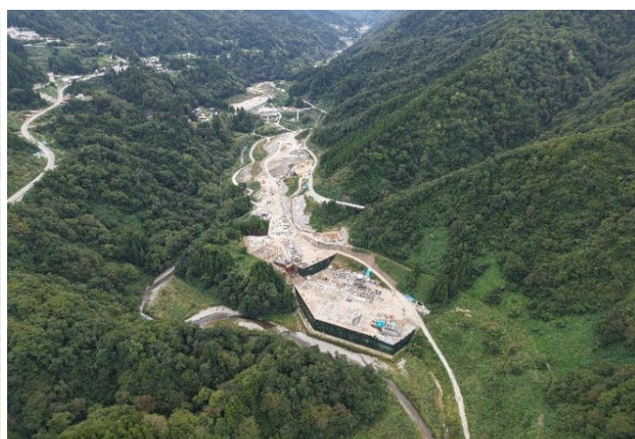
骨材製造設備（下島）の現地状況（R7. 10月初旬）
