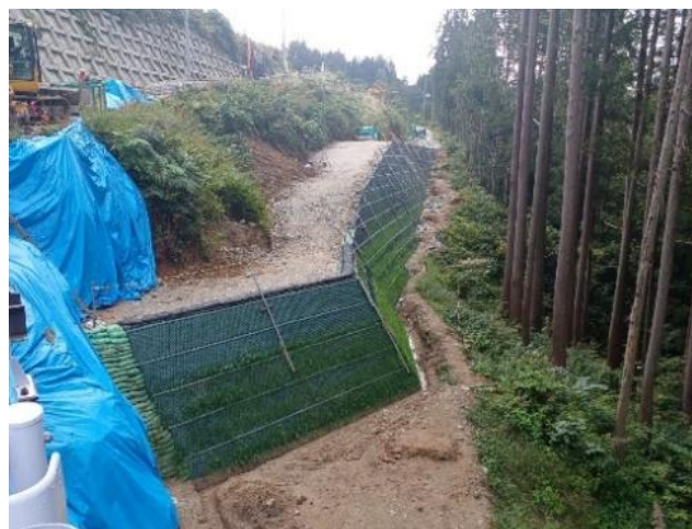
終点側より擁壁工を望む
