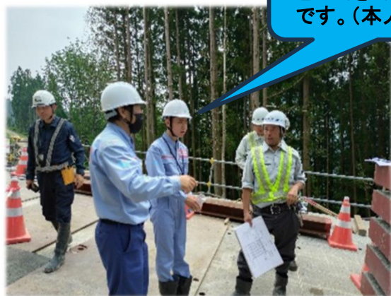
工事現場の立合 （左から3番目で、工事説明を受けている利賀学舎の生徒 赤倉舜也さん）
