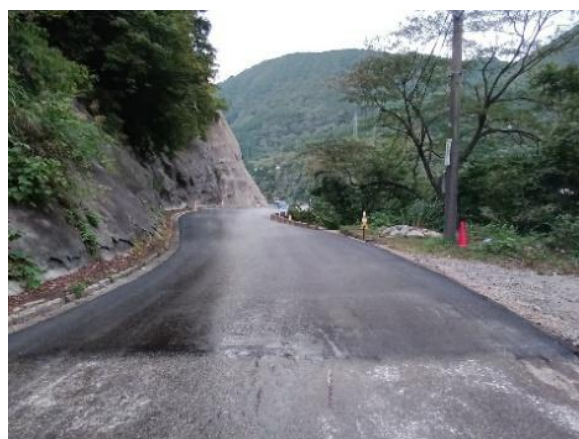
市道栃原線舗装の 打ち換え工事
