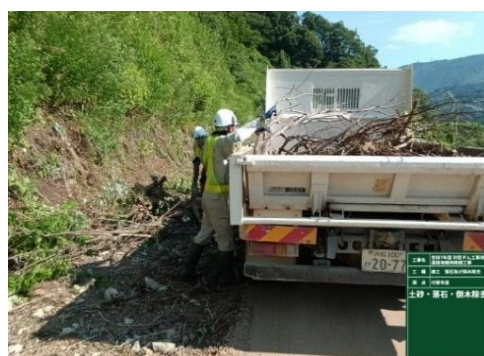
7月 道路の落石・倒木処理
