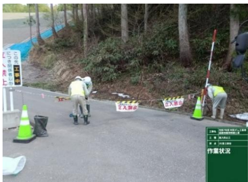
4月 進入防止ゲートの設置
