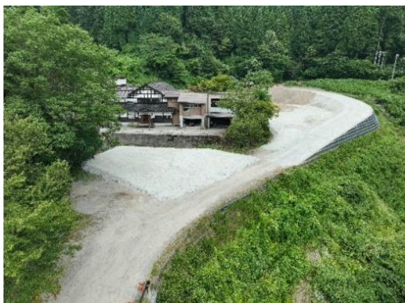
作業ヤード盛土整備 (施工完了)
