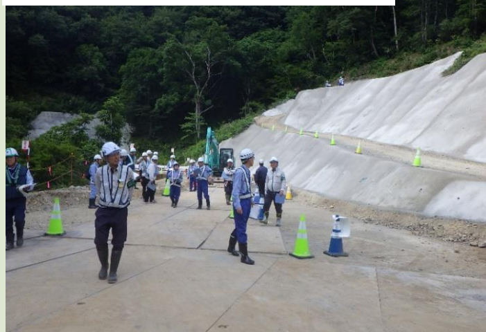
③令和6年度北豆谷地区進入路その3工事
