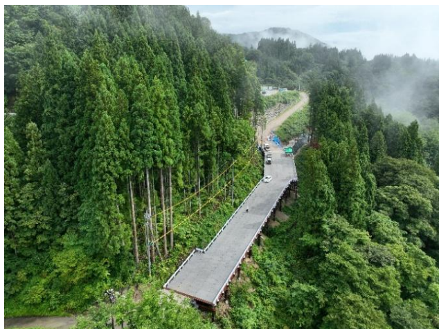
終点側を仮栈橋工を望む
