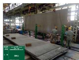
④ I桁組立
