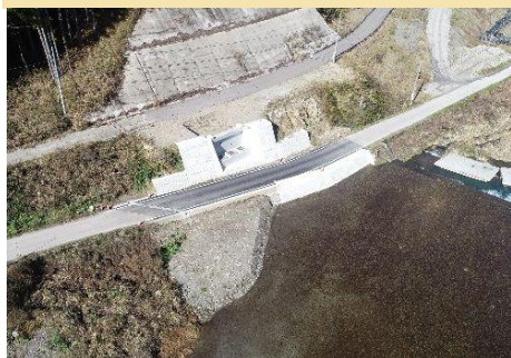
A1橋台護岸工 復旧護岸工 市道舗装復旧 (施工完了)
