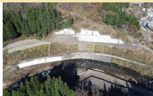
兵谷橋付近の付替市道整備状況 ・掘削工 ・路床盛土工、路体盛土工 ・モルタル吹付工 等
