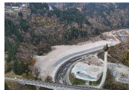
起点側より撮影
