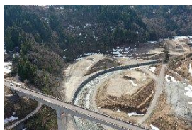
起点側より撮影
