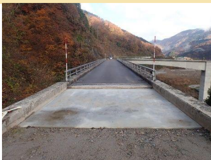
小谷橋A2踏掛版工 (施工完了)
