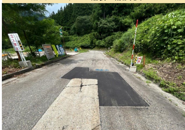
アスファルト舗装 補修完了
