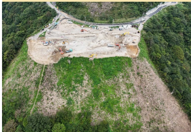
右岸地盤変動域対策工の現地状況（9月中旬）
