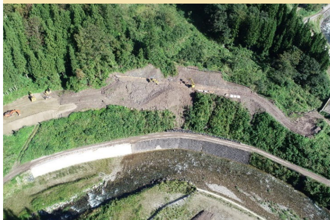
9月中旬の現地状況(付替市道部)
