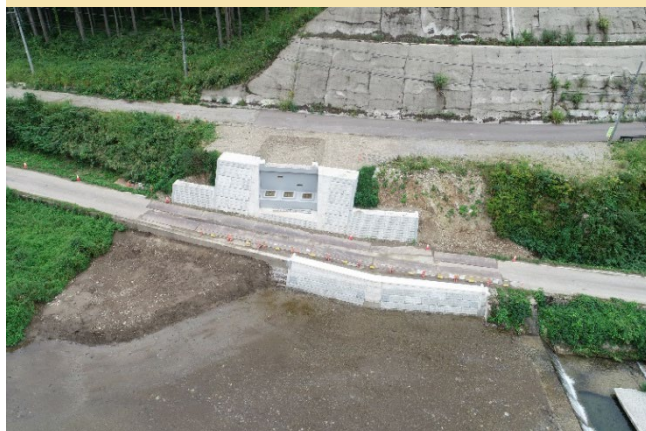
9月中旬の現地状況(新岩渚橋A1橋台護岸工)
