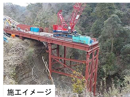
SqCピア工法概要図
