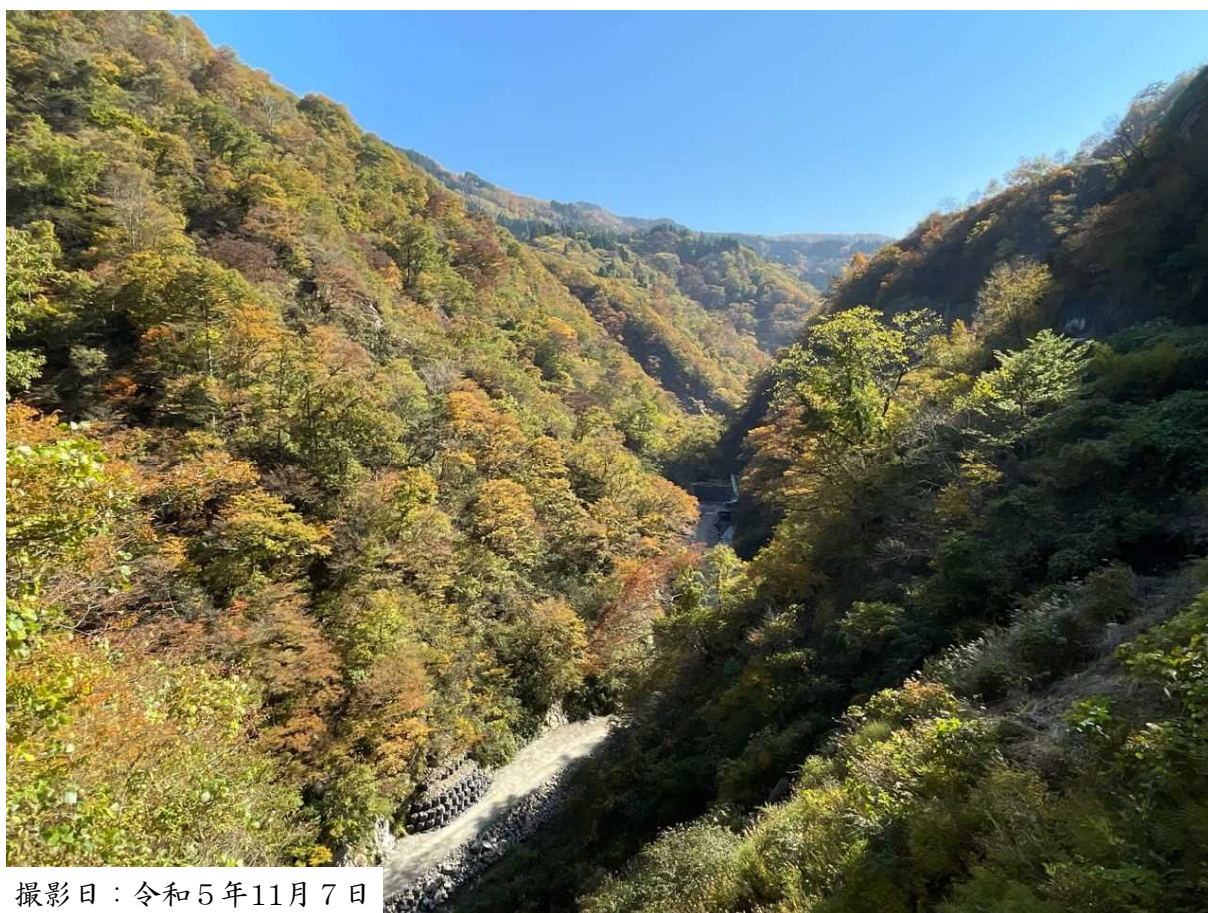
転流工吐口より上流を望む
