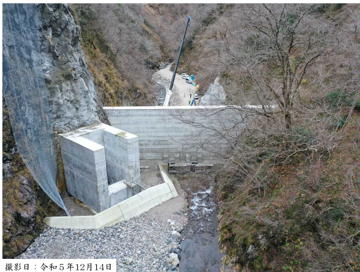
転流工事呑口部
