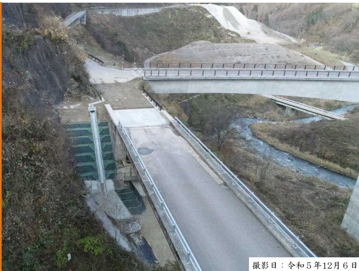
下島大橋上流側付替市道
