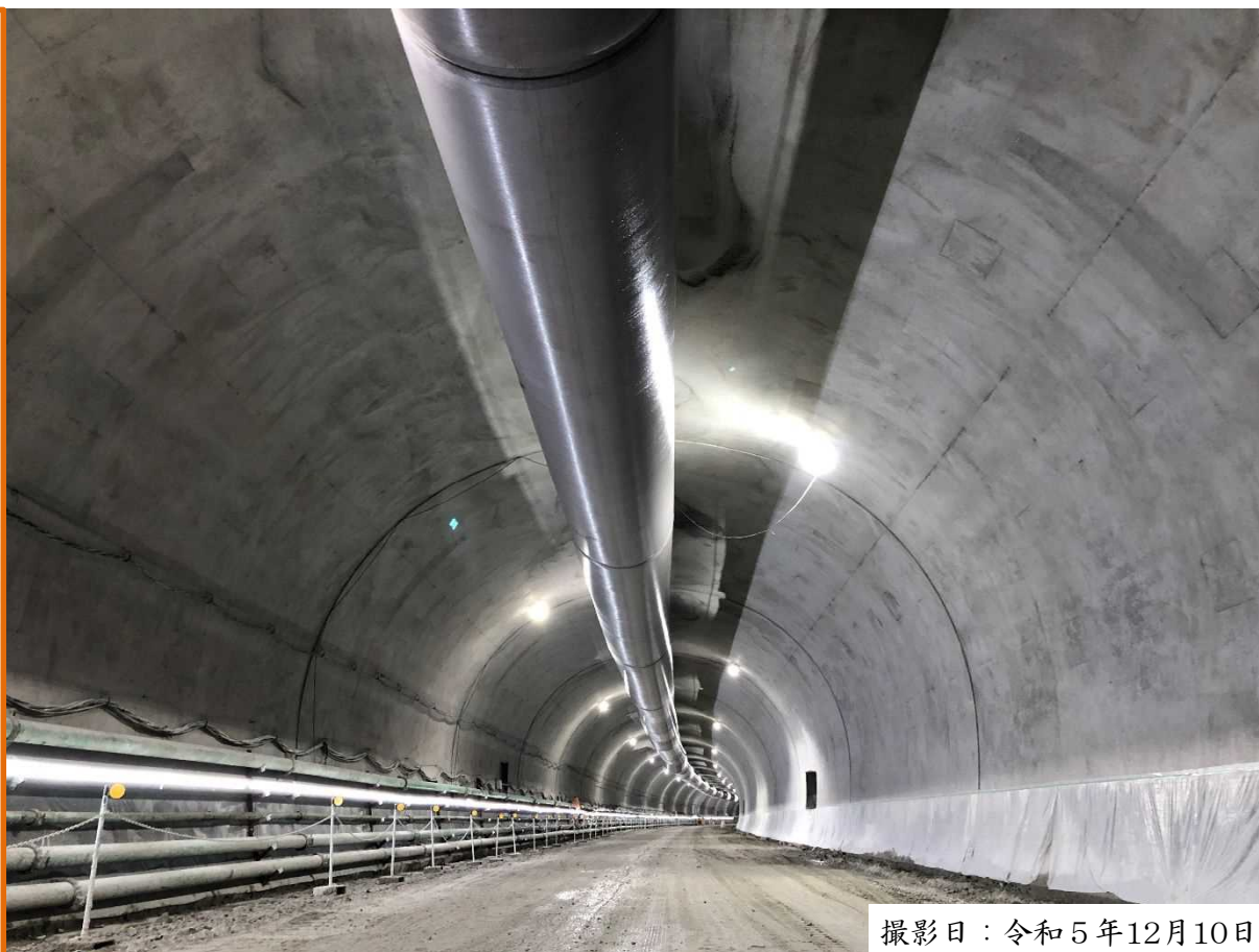
利賀トンネル(仮称)の工事状況(覆工コンクリート完了)
