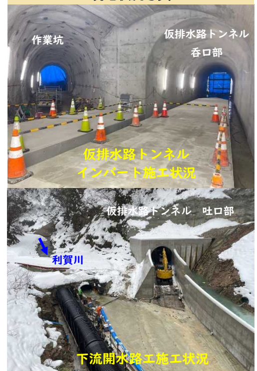
現地状況写真
