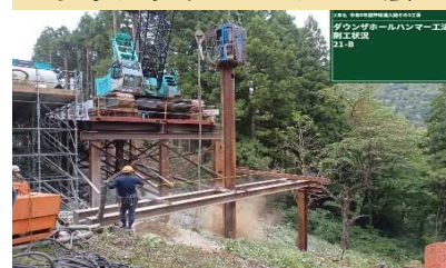
ダウンザホールハンマー工法
