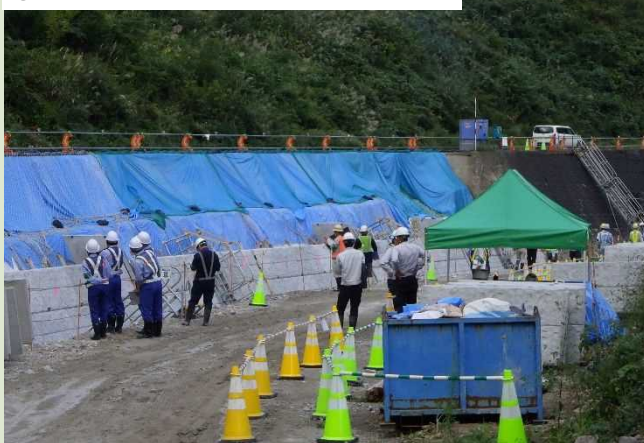
⑪ 令和5年度利賀川護岸整備他工事
