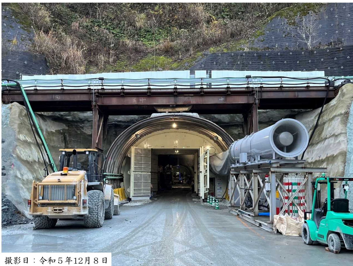
利賀トンネル(仮称)の坑口(防音壁内)
