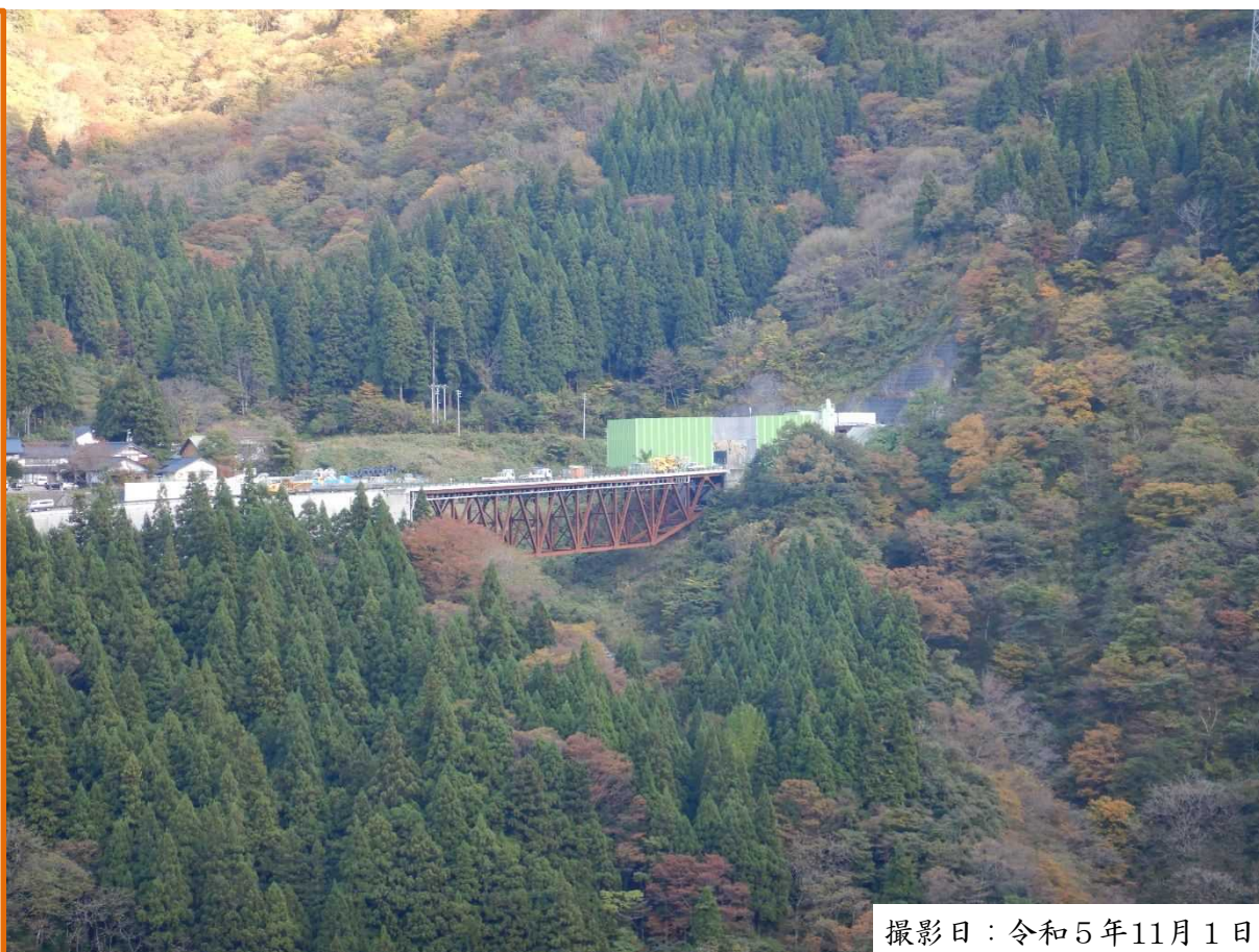
利賀トンネル(仮称)坑口周辺全景(長崎地区)
