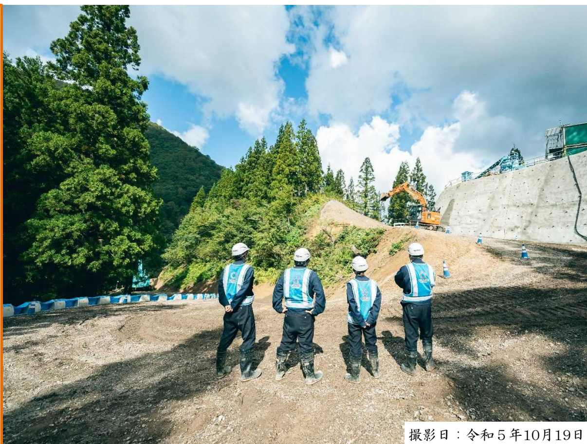
監督員による現場確認
