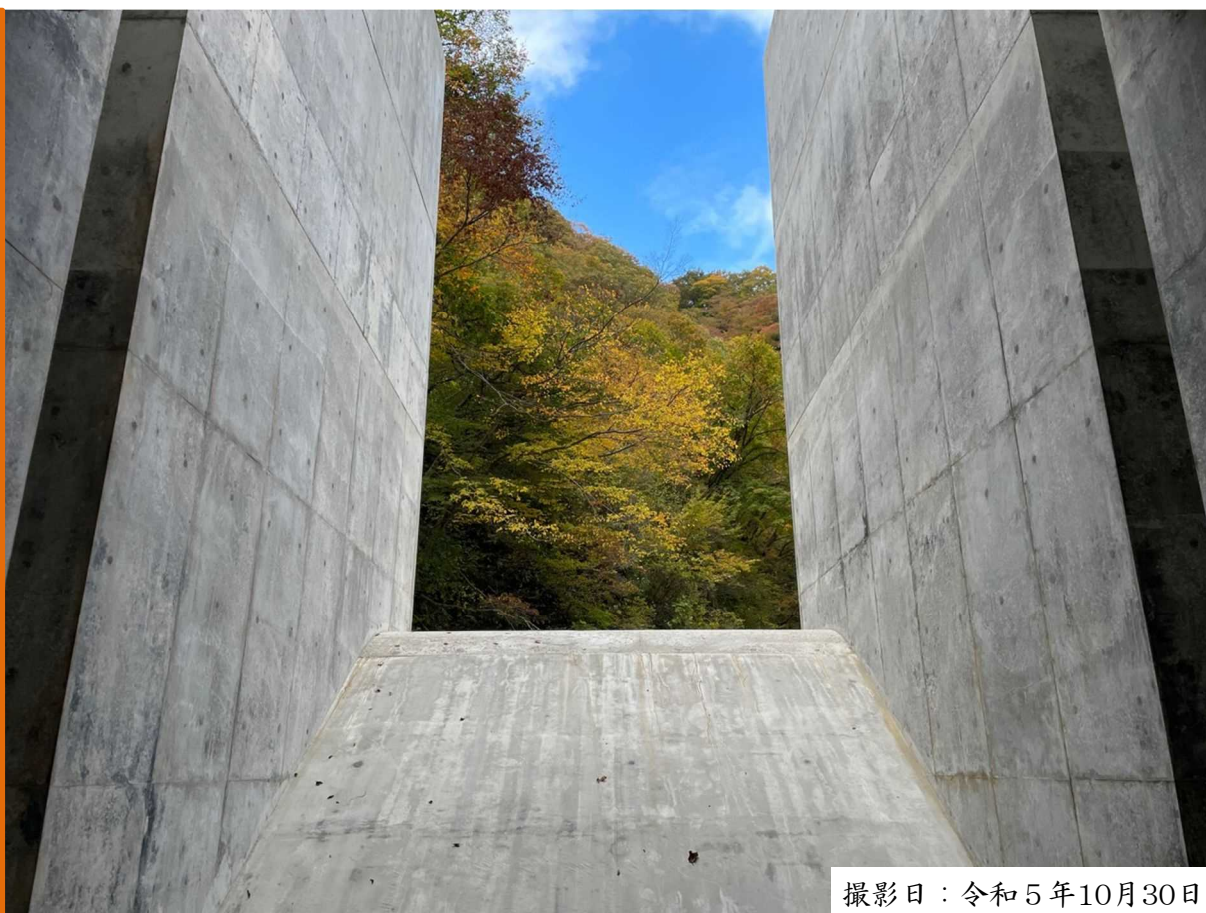
転流工呑口からの外景
