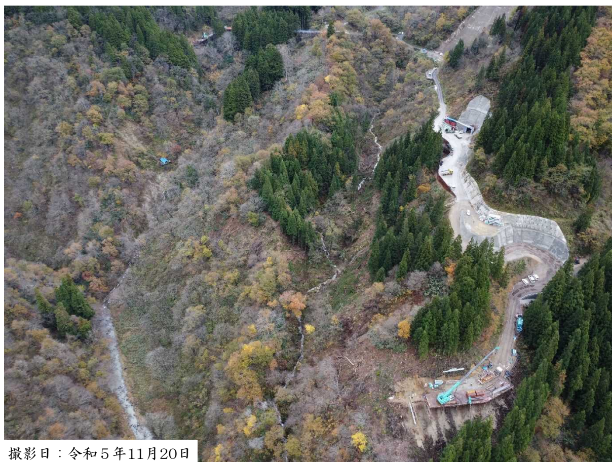
林道下山線の工事
