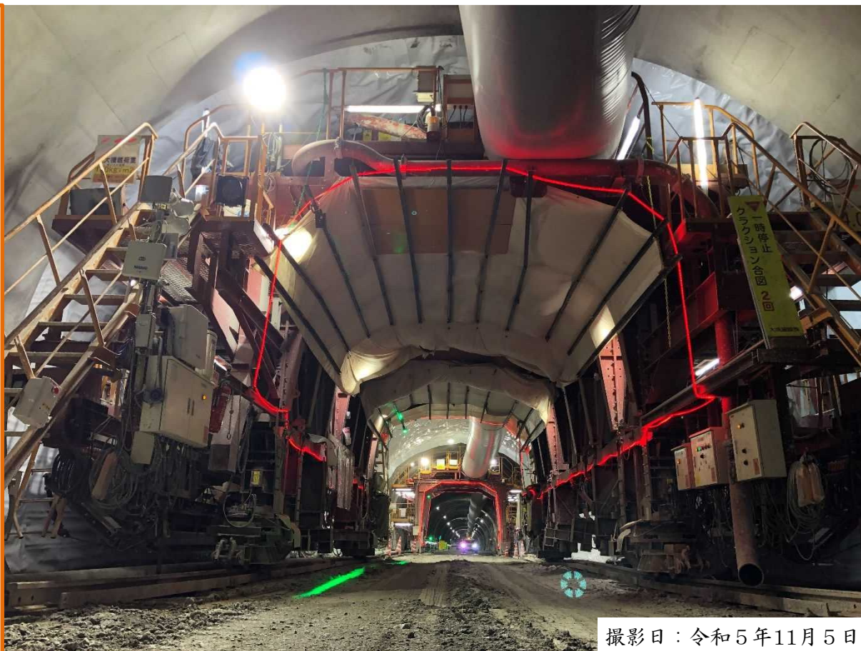
利賀トンネル(仮称)内の工事(覆工コンクリート打設)
