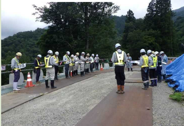
④ 令和5年度北豆谷進入路その2工事
