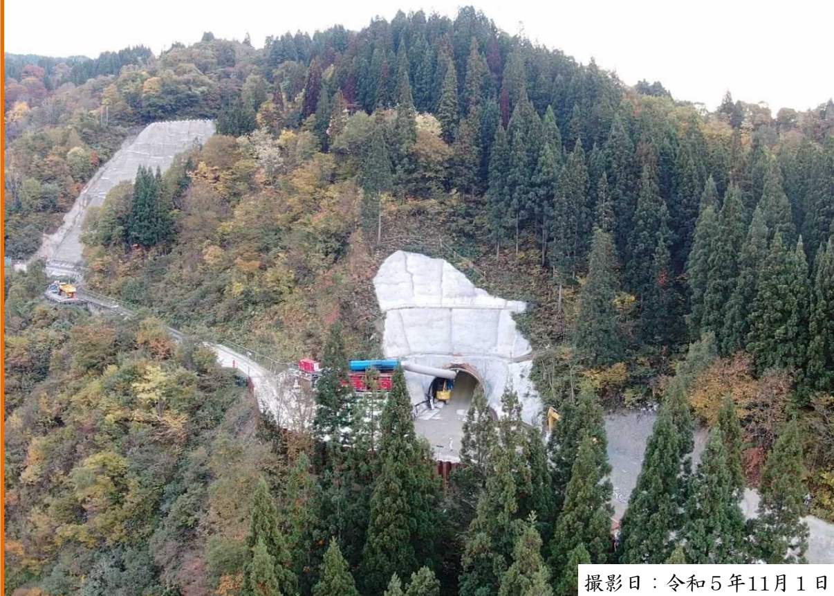
林道下山線内のトンネル坑口（北豆谷トンネル終点側）
