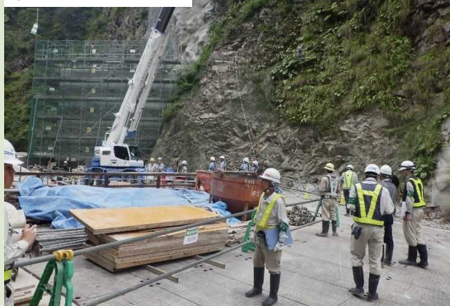
① 利賀ダム転流工事
