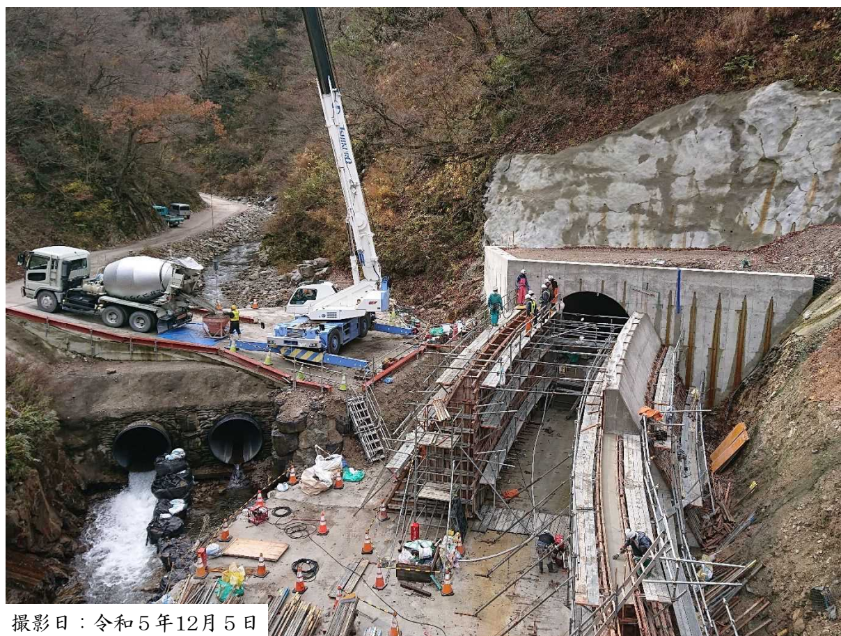
転流工事吐口部
