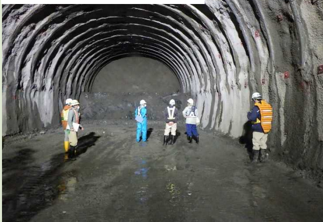
⑭ 利賀トンネル(1工区)工事
