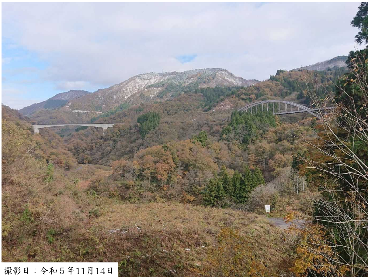
豆谷大橋と湖面橋
