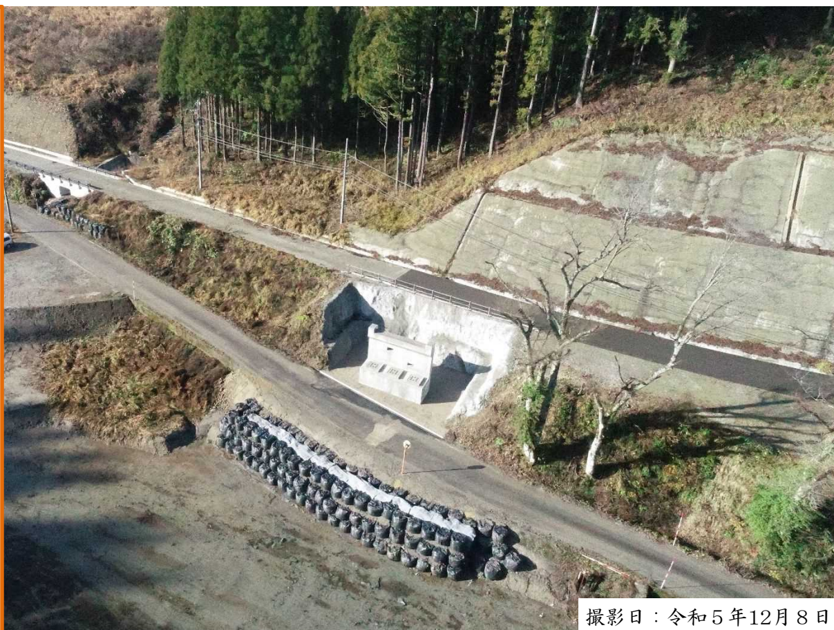
新岩淵橋(仮称)の橋台(左岸側)
