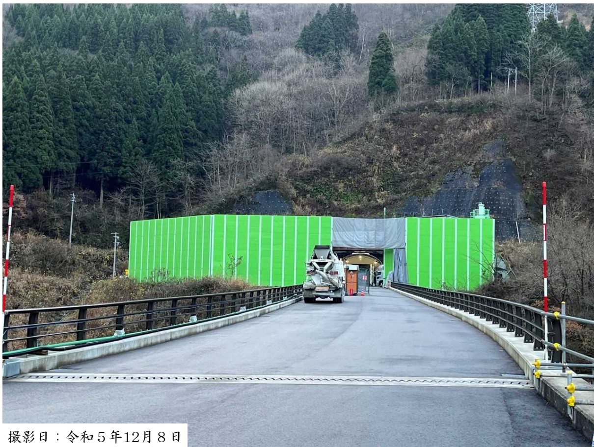
利賀トンネル(仮称)の坑口周辺(長崎地区)
