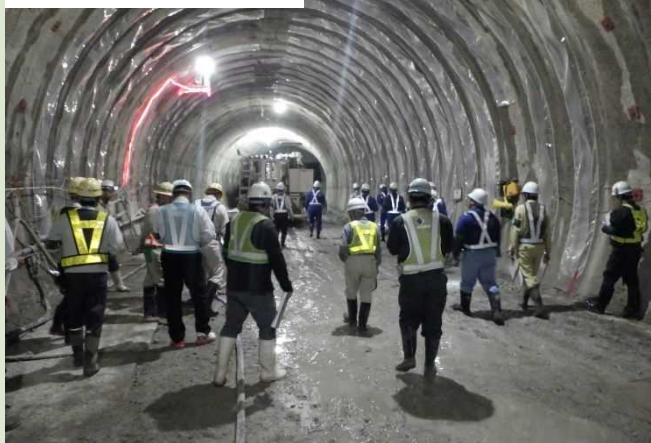
⑤ 北豆谷トンネル工事
