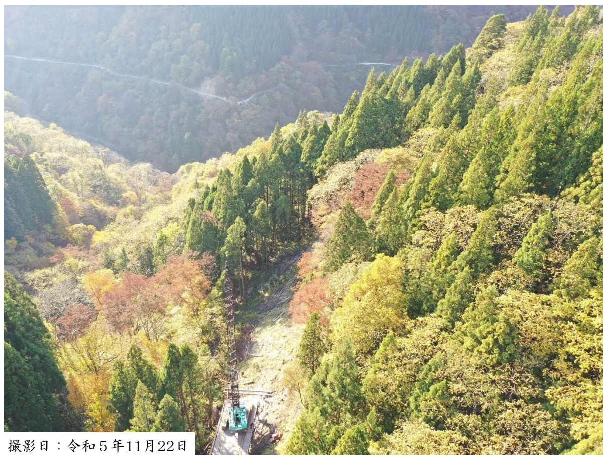
山林内にそびえるクローラクレーン
