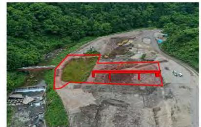
1次掘削(V=6,000m<sup>3</sup>)完了。
