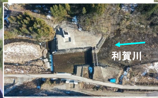
岩渚地区橋梁 令和7年11月時点
