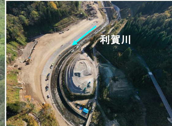
利賀地区盛土 令和7年11月時点
