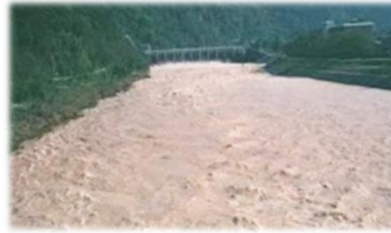
H16.10.台風23号 庄川洪水観測史上最高水位を記録 2,840名に避難勧告
