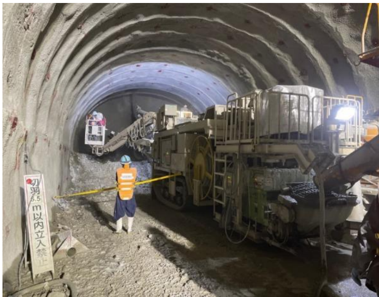
切羽監視状況
