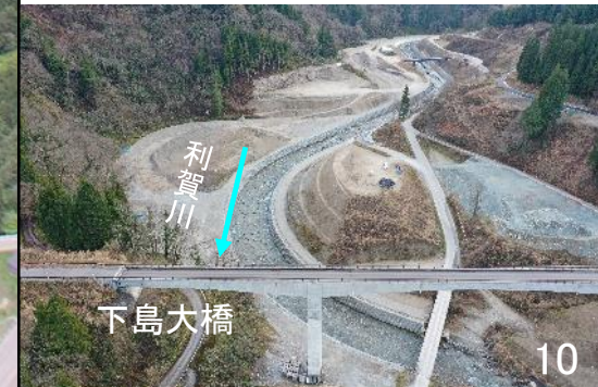
現地状況 令和4年11月時点
