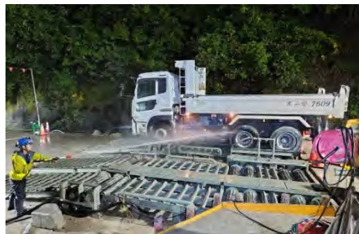
汚濁対策設備（タイヤ洗浄状況）
