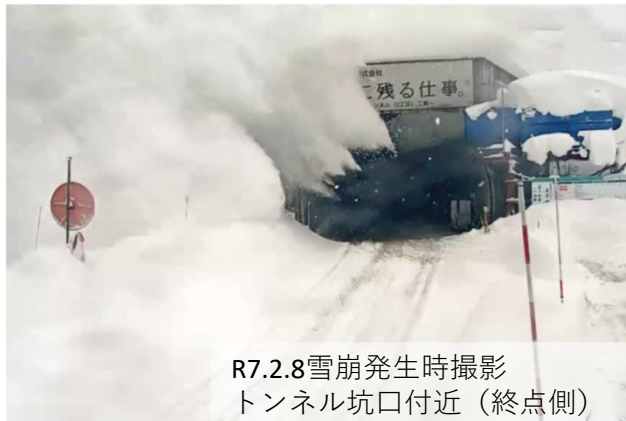
【赤松谷雪崩発生状況】
