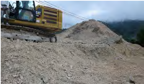
発生土の仮置き状況
