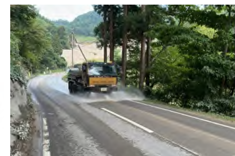
散水車による路面清掃状況
