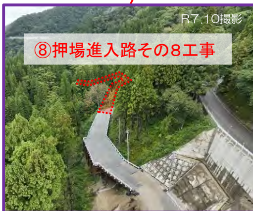
押場線 (押場進入路その8工事)
