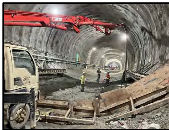
インバート打設状況
