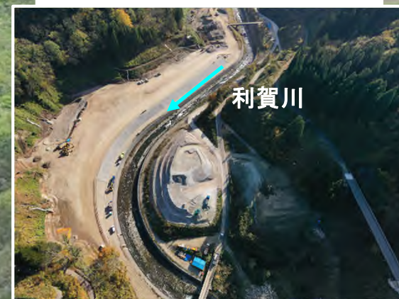
利賀地区盛土 令和7年11月時点
