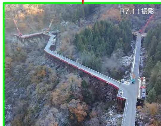
押場シャフト線・排水トンネル線 (完成)
