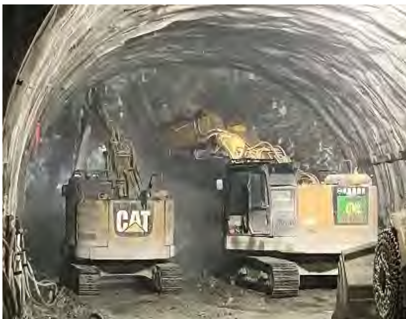
トンネル掘削状況
