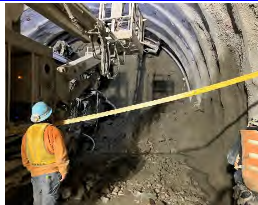
支保建込状況
