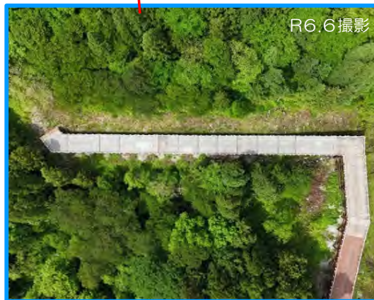
下山押場線 (完成)
