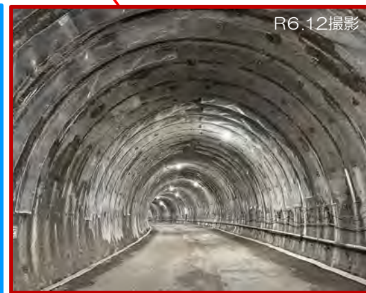
北豆谷トンネル (完成)
