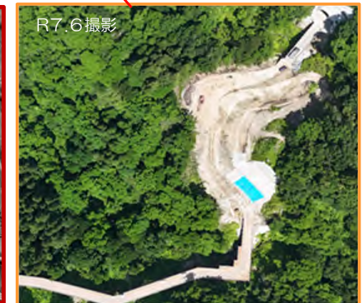
北豆谷線 (北豆谷進入路その3工事)
